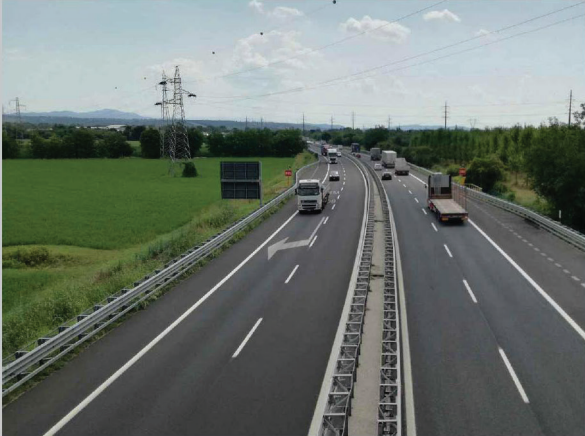
A - vista da sovrappassaggio su A4 verso il Carso, Villesse
