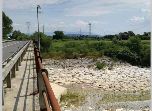
D - vista dal ponte SR 351 sul fiume Torre verso il Carso, Villesse
